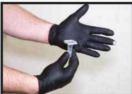
01 : Roulez le port d'injection dans la PÂTE DE PRÉPARATION DE SURFACE POUR RÉPARATION DE FISSURES DRICORE<sup>MC</sup> PRO RÉPARATION DU BÉTON.
